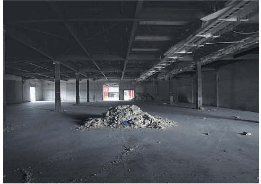
Im nördlichen Trakt, näher am Gleisfeld, beginnen Ende Mai die Abbrucharbeiten.
