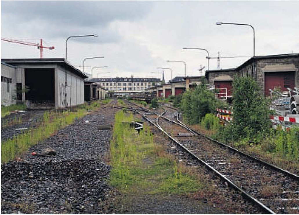
Die Anordnung der Laderampen wie Sägezähne im Güterbahnhof von 1897 war eine Pionierleistung.
